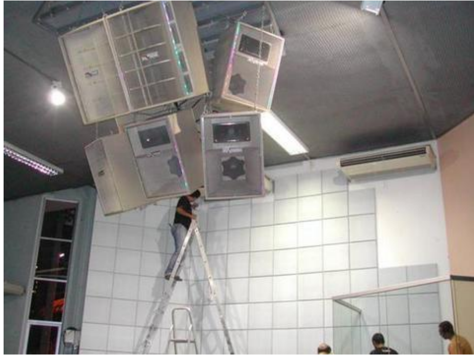
Projeto de cluster central, um conjunto de caixas acústicas utilizado junto ao teto. Cada caixa é “apontada” para uma região diferente da igreja.
